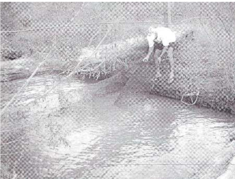
Foto 5: Tela metálica de proteção ao canal da bomba de irrigação.
